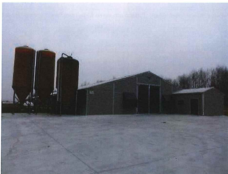
Figure 1 : Bâtiment d'élevage avicole V3 (exploité en 2013)
