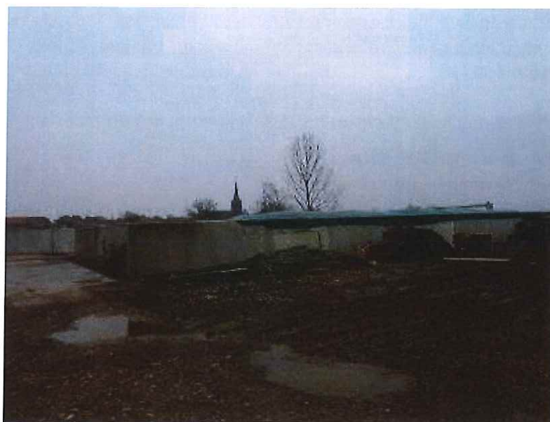
Figure 2 : Plateforme de compostage des effluents produits sur l'exploitation
